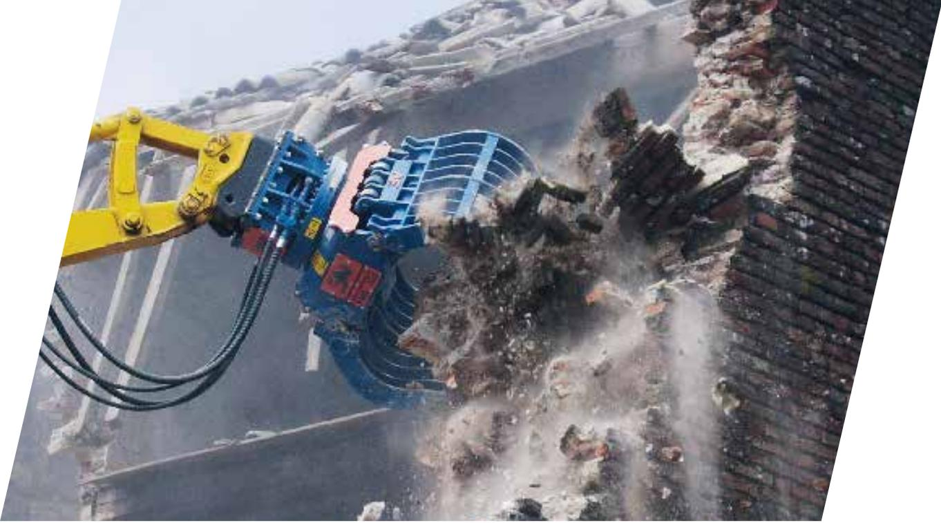
**ITA** - Pinze demolitrici e selezionatrici ideali per la demolizione di strutture e fabbricati di media consistenza, per la selezione mirata e il carico dei materiali di risulta in cantiere e in discarica, per una specifica separazione e movimentazione dell'inerte nei centri di riciclaggio e nella riqualificazione ambientale.
